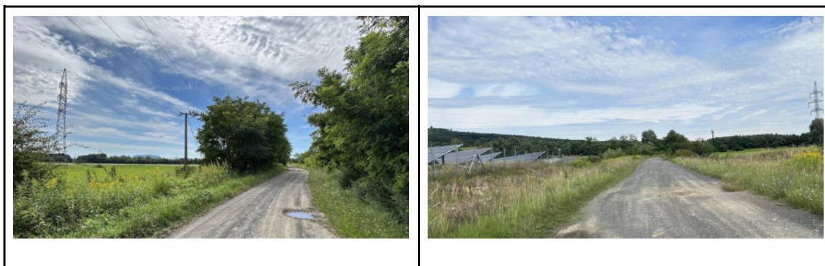
4. fotó: A tájvédelmi hatásterület a megjelenő antropogén elemekkel
